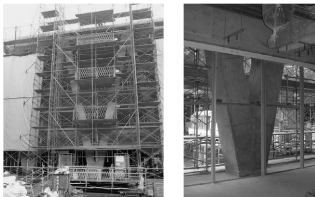
写真4 工事中のV字柱 (左：外観、右：室内側)
