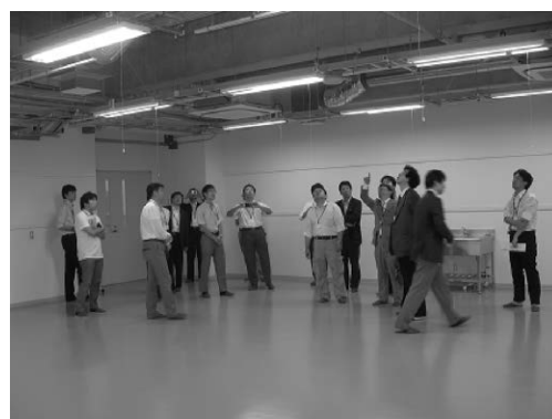
写真7 天井の空調室内機の説明状況
