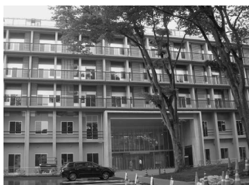
写真6 見学時の建物外観
