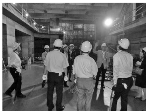
写真5 工事中の免震層での説明状況
